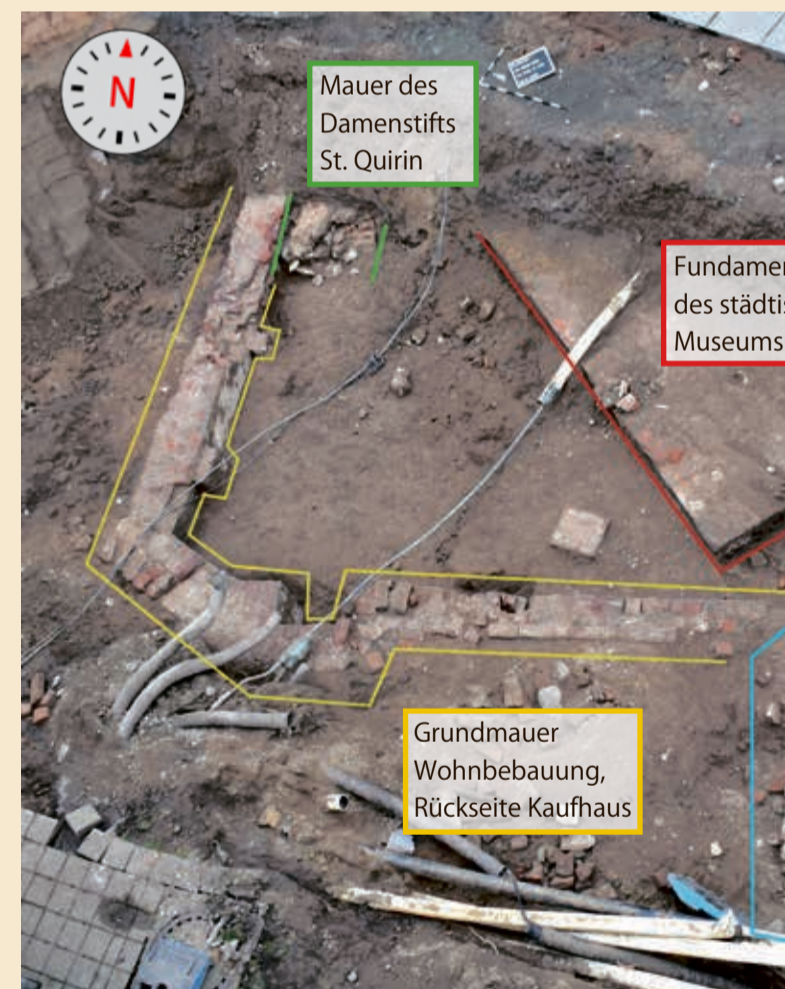
Die durch die Bauarbeiten freigelegten Mauern sind mittlerweile wieder eingeebnet.
