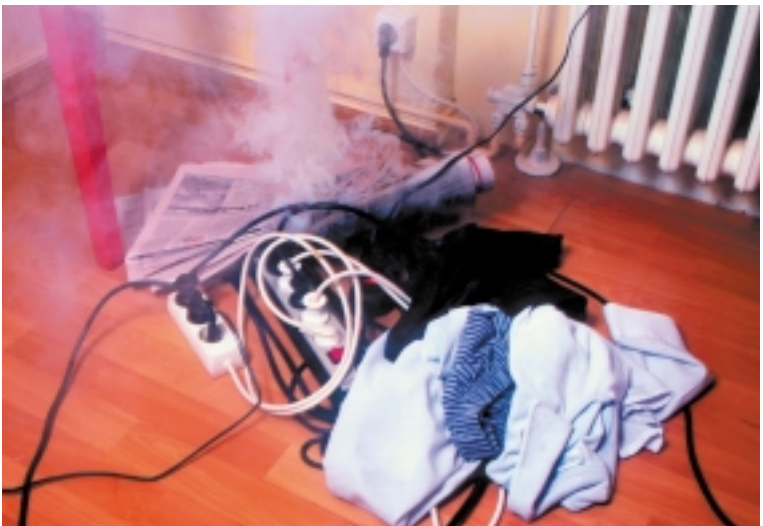
Abb. 1: Beispiel für die Folgen einer überlasteten Stromleitung
