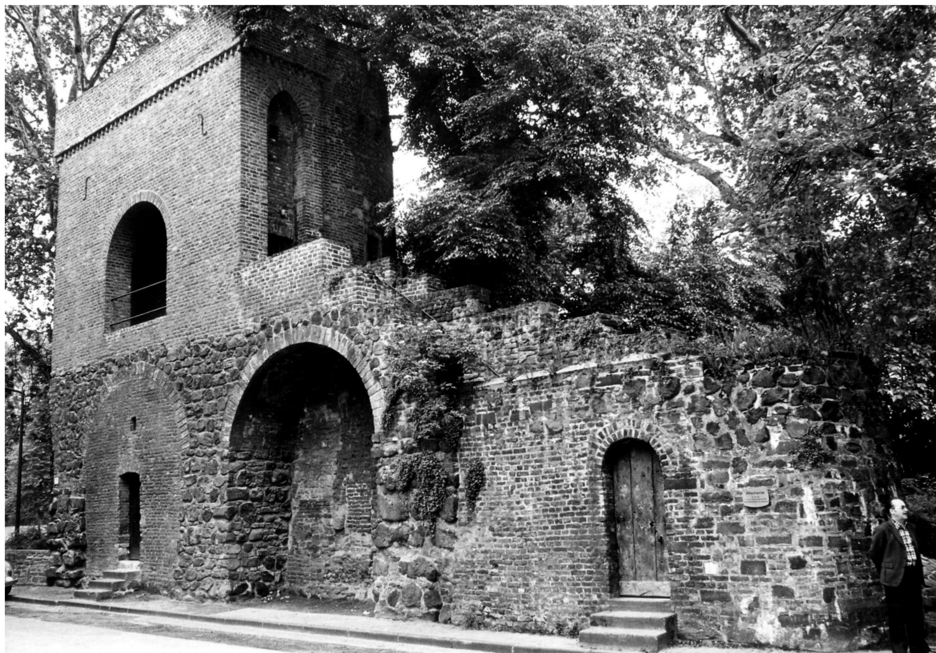
La tour du Sang avec ses arcs de soutènement côté ville et son accès depuis la Promenadenstraße, vers 1970
